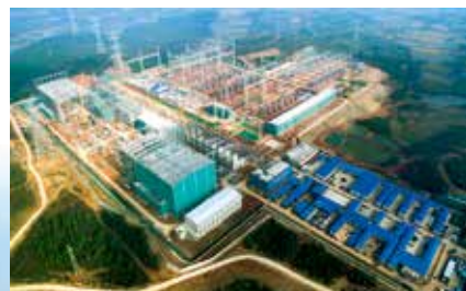
拥有多项世界之最的昌吉—古泉±1100kV特高压直流输电工程宣城古泉换流站
